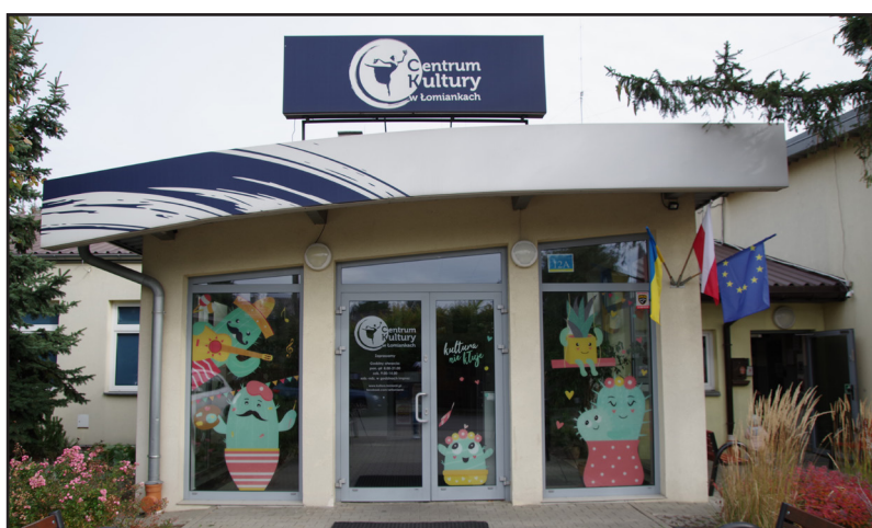
Wejście główne do budynku
